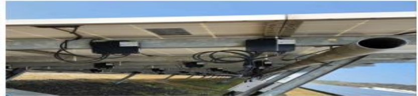
그림 전력용변환기 설치어레이 및 미설치어레이
